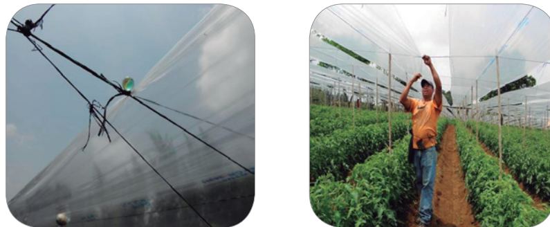
Figura 36. Sistema de amarre del plástico entre los lomillos.
